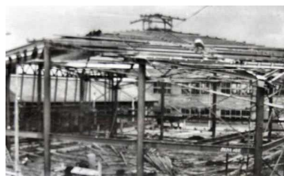
【▲新屋体建築工事】
