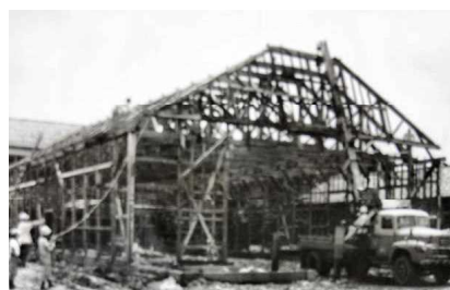
【▲旧屋体解体工事】
