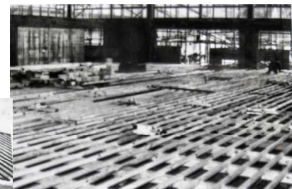
【▲新屋体床工事】
