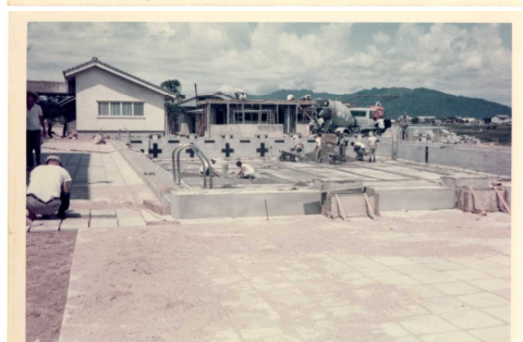
【▲昭和48年プール建設工事の様子】
