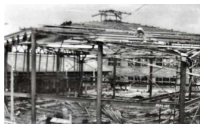
【▲新屋体建築工事】
