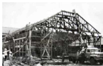
【▲旧屋体解体工事】
